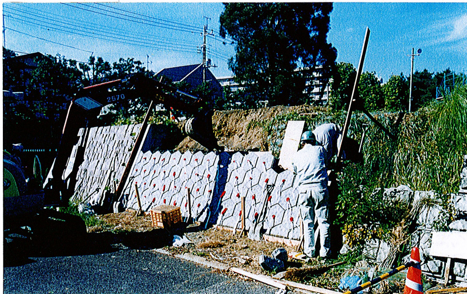
5段目施工状況
