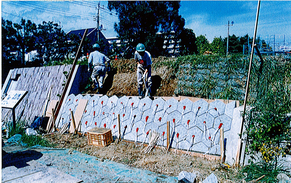
4段目施工状況
