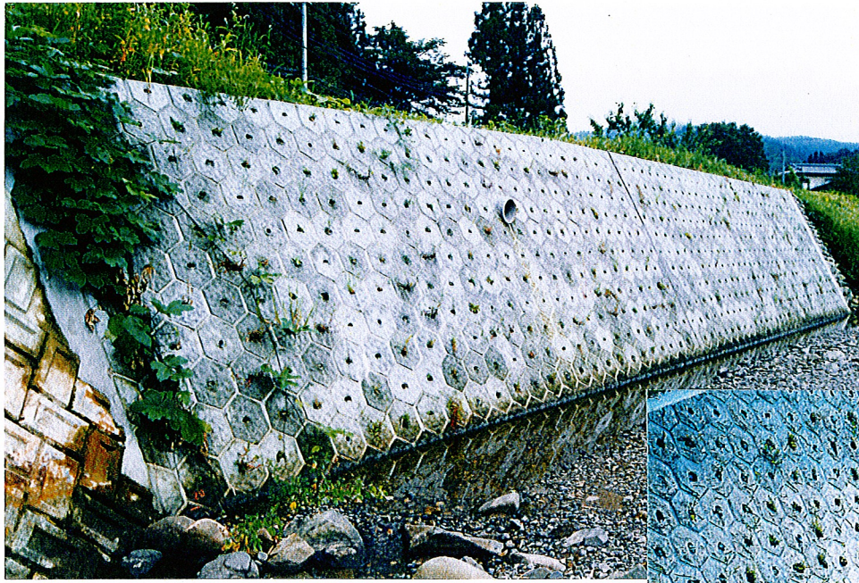
施工完了年度
