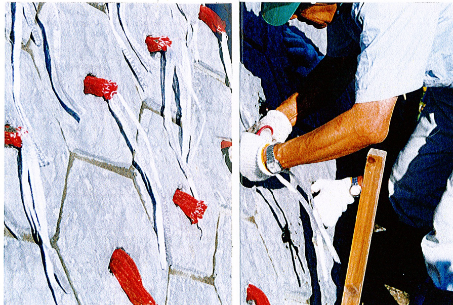
土のう(余分)カット状況
