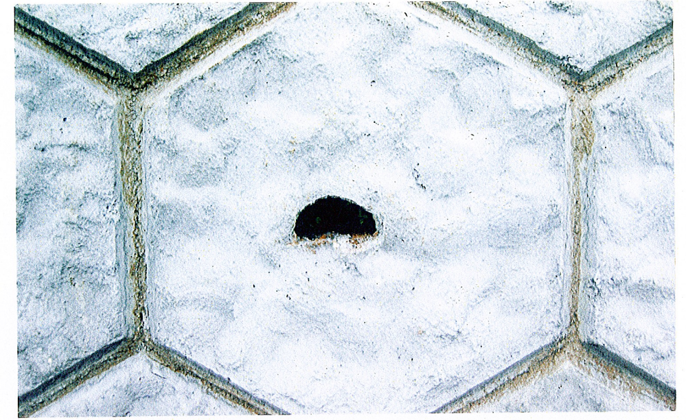
点穴より植物の芽が出てきた(施工3週間目)
