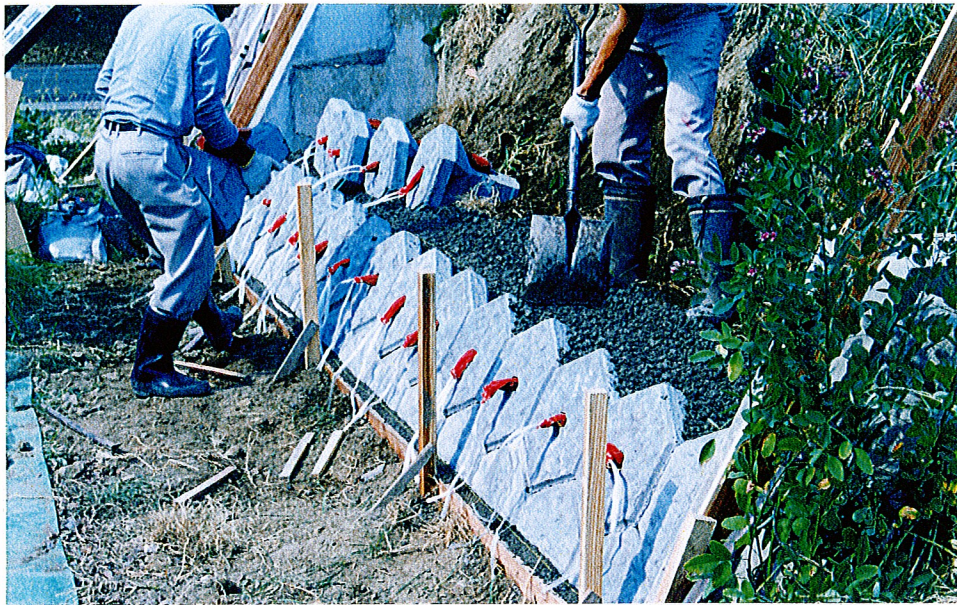
3段目施工状況
